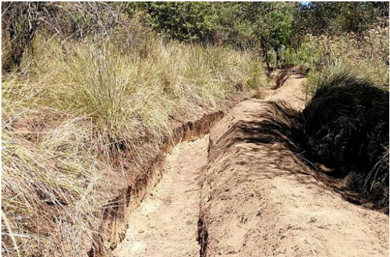
Imagen 30. Canales de drenaje
